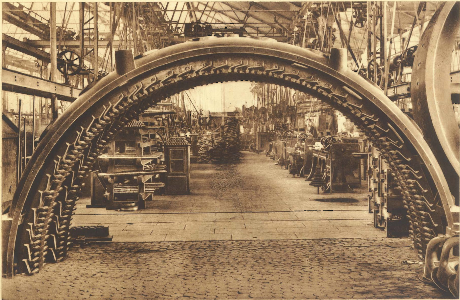
Estator del mayor generador construido en España.
